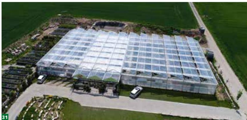
**30 Grünes Zentrum Schopf, 90453 Nürnberg-Krottenbach (Kräss GlasCon)** Einschiffiges Verkaufsgewächshaus mit einer Fläche von rund 520 m<sup>2</sup>, Konstruktion mit Alu-Profilen Vario Basic Thermo 26 und einem Sonnenschutzglas in Grün. Anlage komplett mit Schattierung, Heizung und RAM-Klimacomputer einschließlich Schaltschrank. Fertigstellung 2020.
